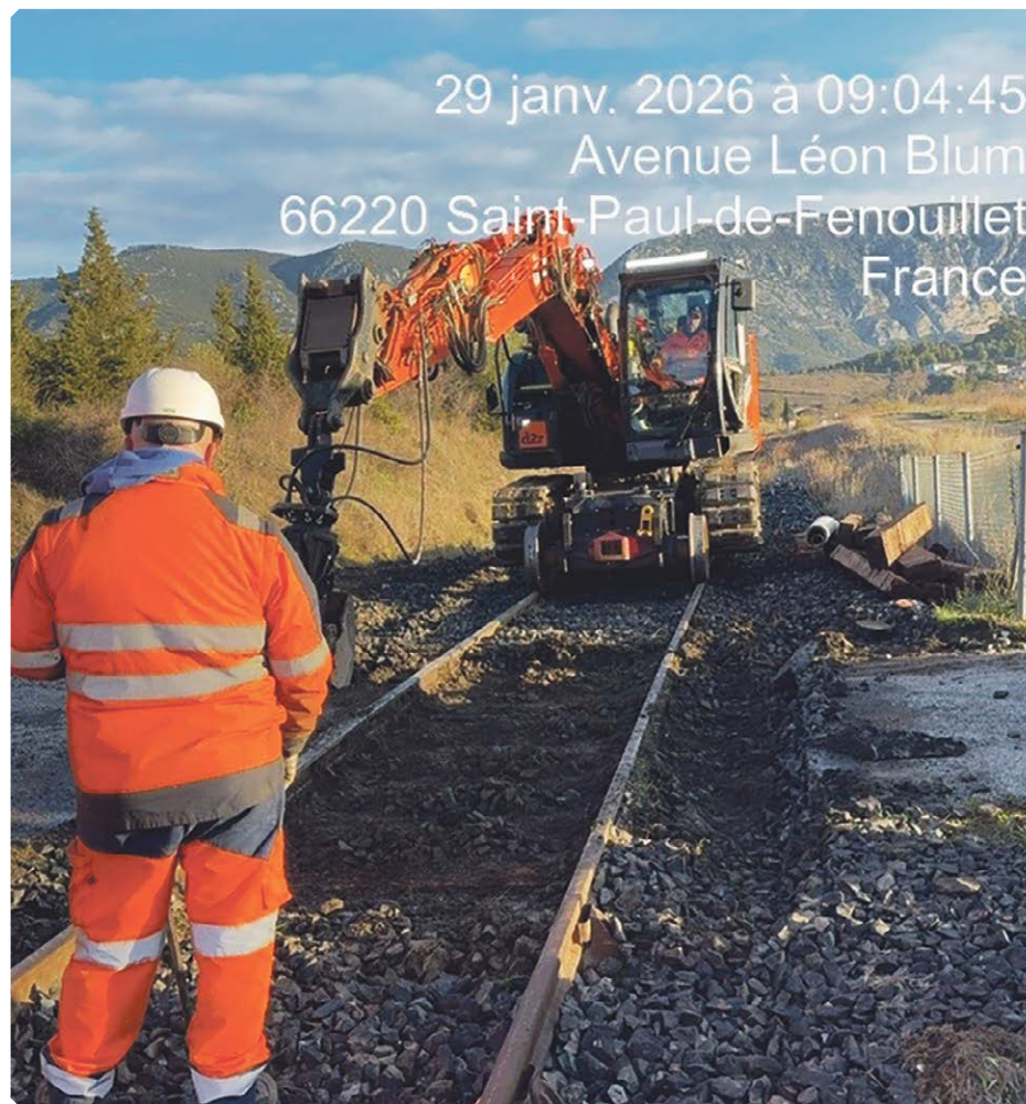
Opération de platelage © Yves GUIMEZANES
