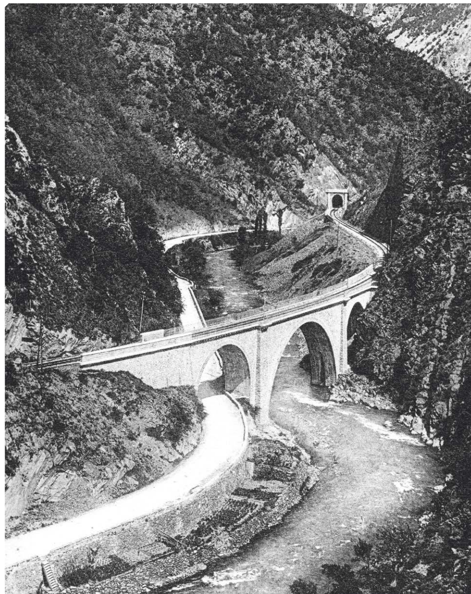
Azat - Entrée du tunnel côté Quillan ©DR
