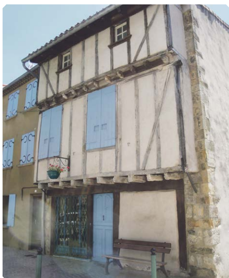
Maison à colombages dans Caudiès © CCAF
