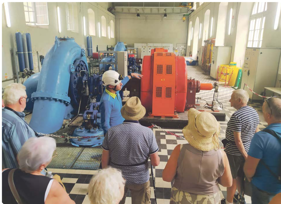
Visite de la centrale EDF St-Georges près d'Axat pour les passagers du train ©SMTRCF
