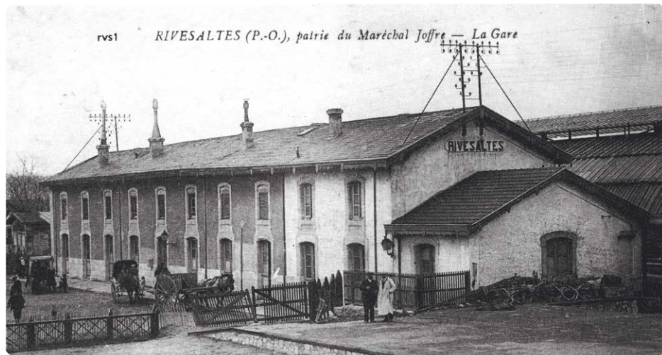
Rivesaltes côté cours marchandises en 1900 ©DN
